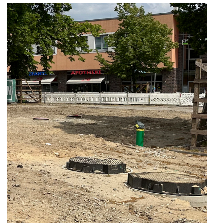
Nur die Schachtabdeckungen sind oberirdisch gut zu erkennen
