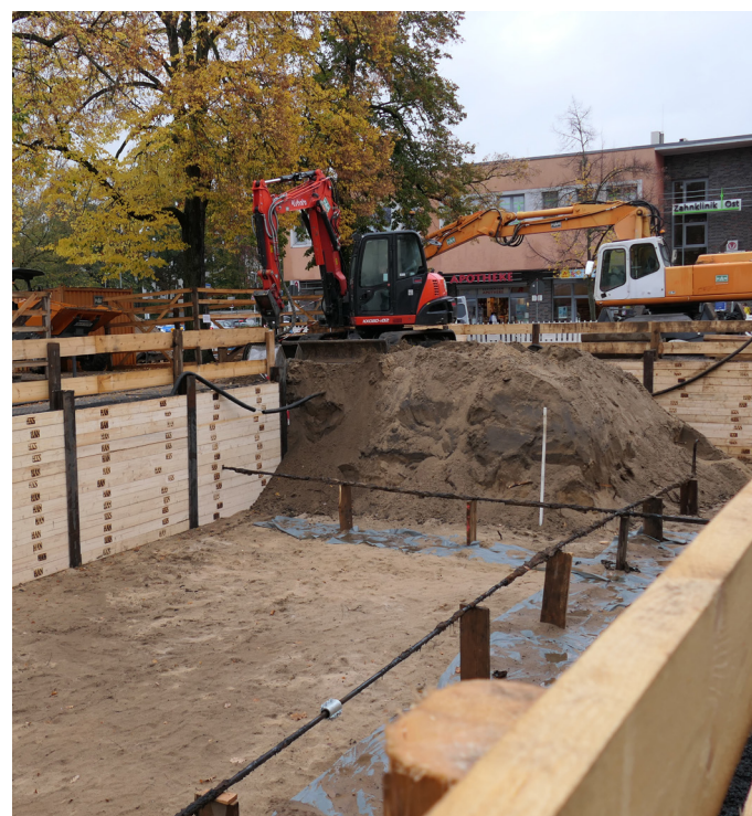
Bauarbeiten am Marktplatz im Oktober 2022
