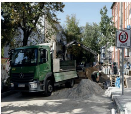
Seit Mai 2023 nun wird die Fahrbahn auf dem Teilstück zwischen Dörfeld- und Altheider Straße erneuert. Die Überarbeitung führt zu einer besseren Wasserableitung und zu einem ebenen Fahrbahnniveau.
