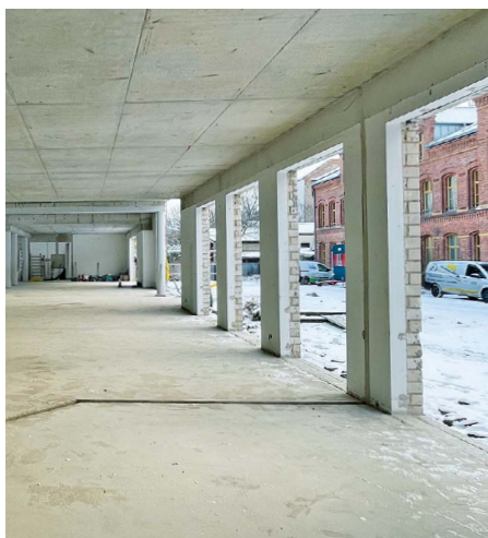
Die Arbeiten am zweiten Bauabschnitt
